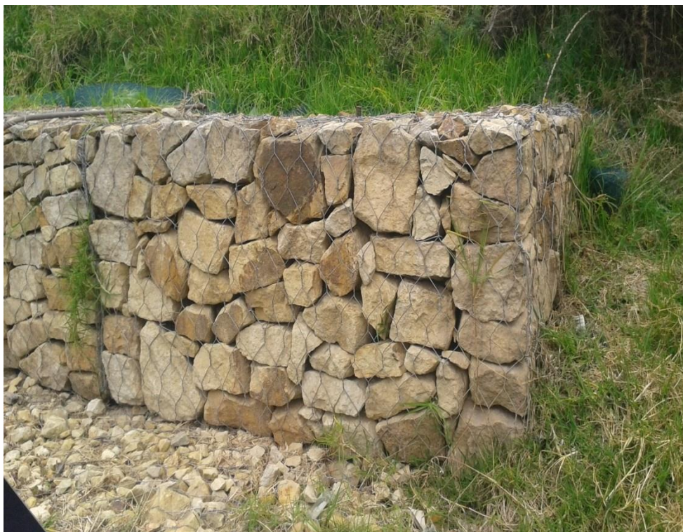
Fotografía 4. Punto de intervención en el CER de la quebrada El Chuscal, para la construcción de las obras de estabilización y contención de la carrera 18 Este.
