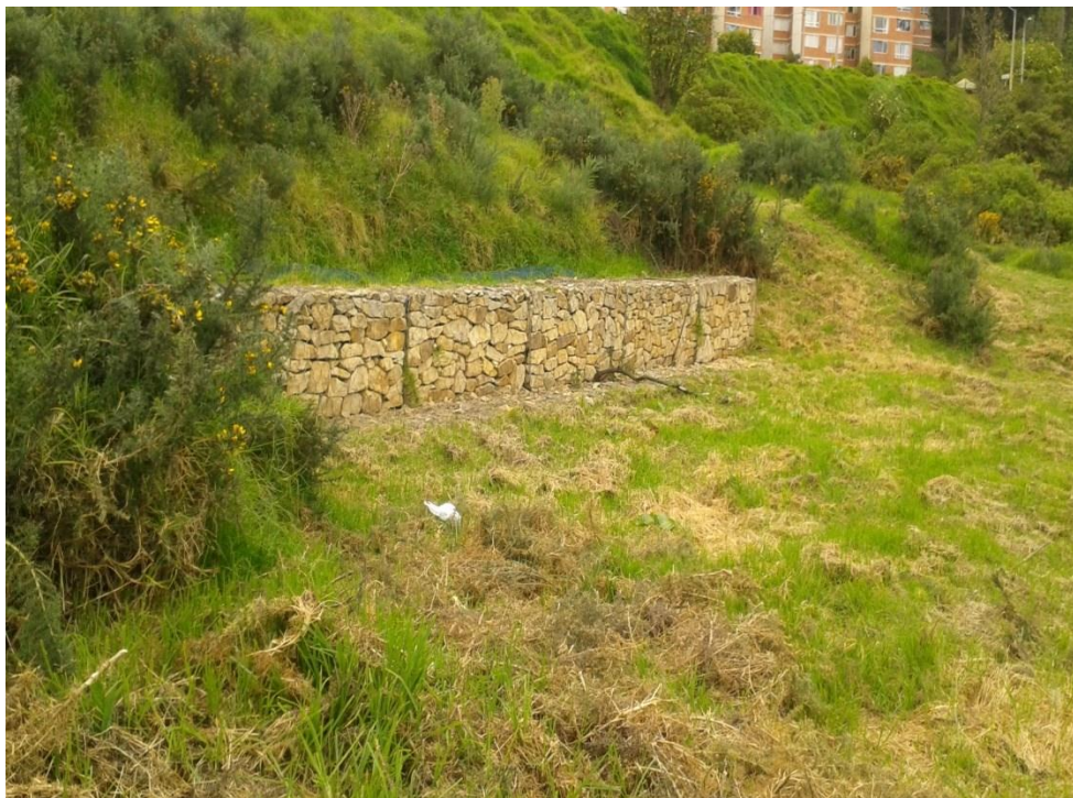
Fotografía 5. Punto de intervención en el CER de la quebrada El Chuscal, para la construcción de cunetas de drenaje.
