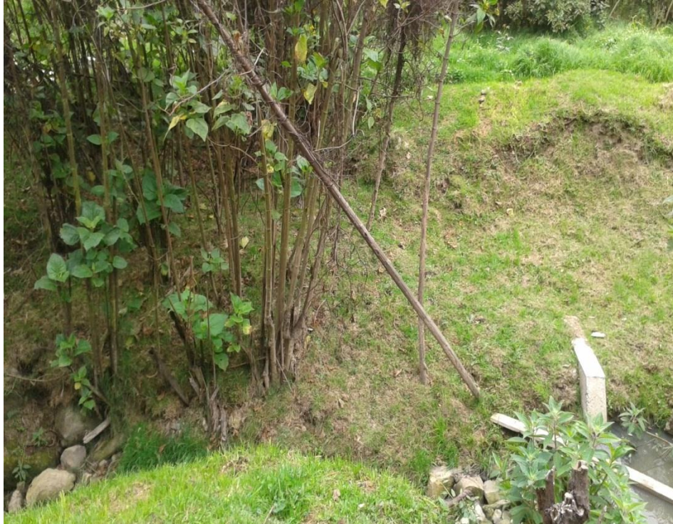
Fotografía 6. Punto de intervención en el cauce de la quebrada El Chuscal, para la construcción de entrega del drenaje subsuperficial.
